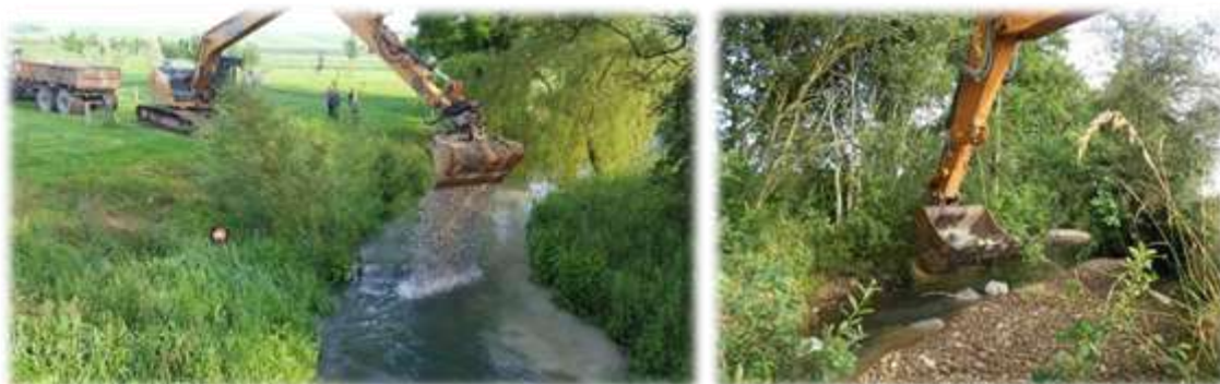
Figure 115 : Exemple d'opérations de recharge granulométrique (FDAAPPMA 59 et SMAR Loir)
