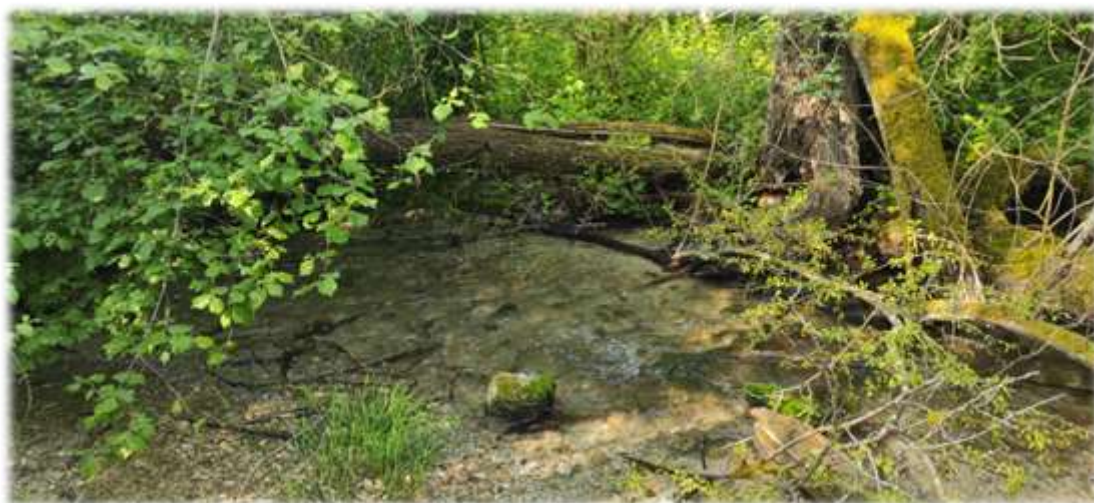
Figure 91 : Ensemble des observations réalisées et illustration photographique du tronçon n°6 sur la Loire
