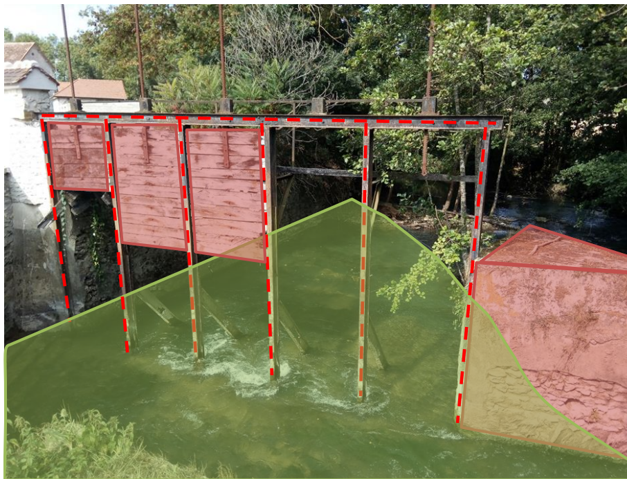
Figure 13 : Moulin de Court - Effacement des vannes et du muret et reprofilage de berge en rive gauche
