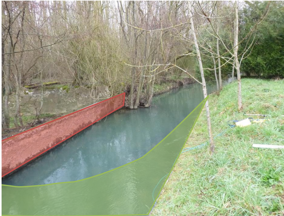
Figure 12 : Moulin de Court- Effacement du muret en rive droite et reprofilage de la berge rive gauche
