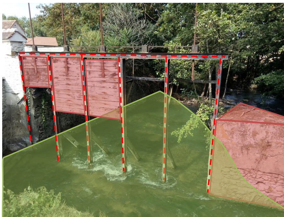
Figure 13 : Moulin de Court - Effacement des vannes et du muret et reprofilage de berge en rive gauche
