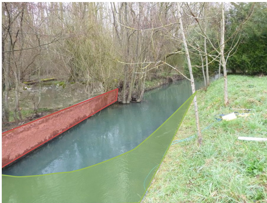
Figure 12 : Moulin de Court- Effacement du muret en rive droite et reprofilage de la berge rive gauche
