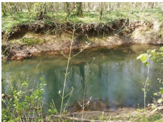
Erosion de berge et élargissement du lit
