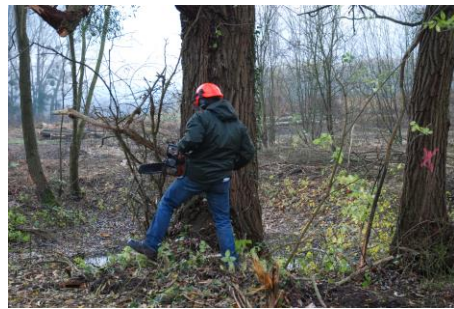
Exemple de travaux forestiers
